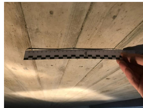
Wellenförmige Untersicht des Überbaus von Brücke 1
