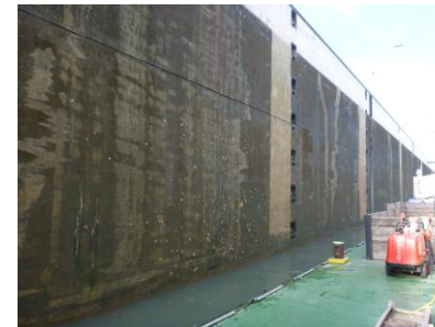
Schleuse 2 Niedersachsen Kanal Hildesheim CEM III/A Bj. 2007-2012
